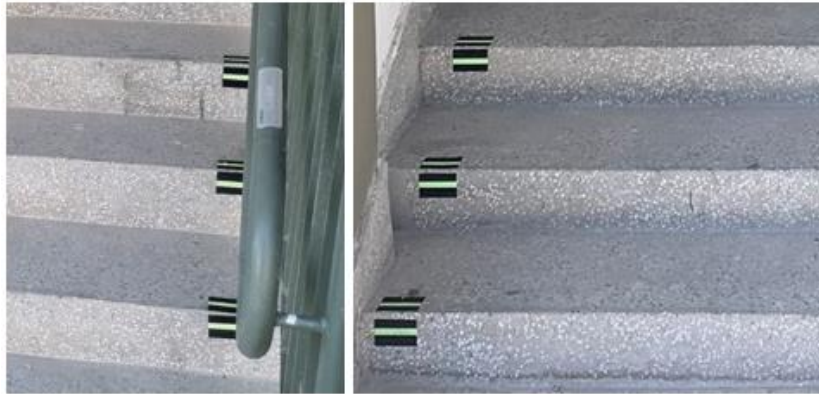
Figura 22 - Sinalização tátil. Degraus com sinalização visual.
