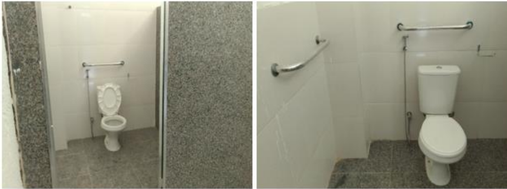
Figura 20 - Banheiros do prédio 1.
